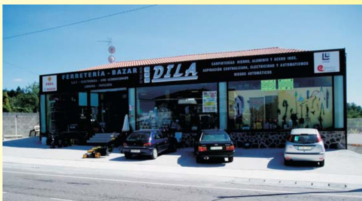
Vista exterior de Ferretería-Bazar DILA
